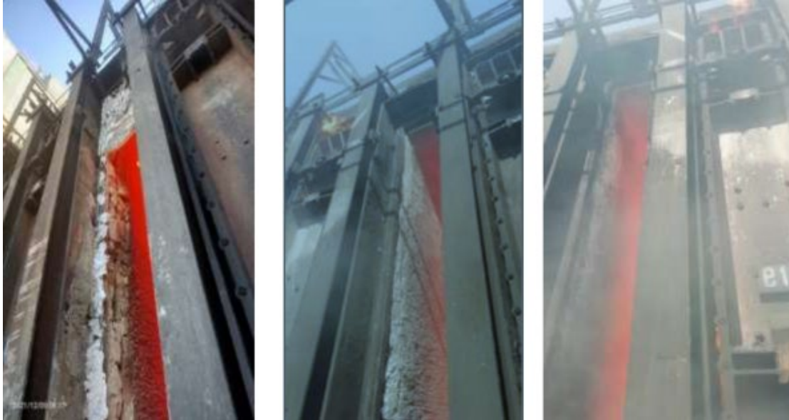
Komory před a po opravě
